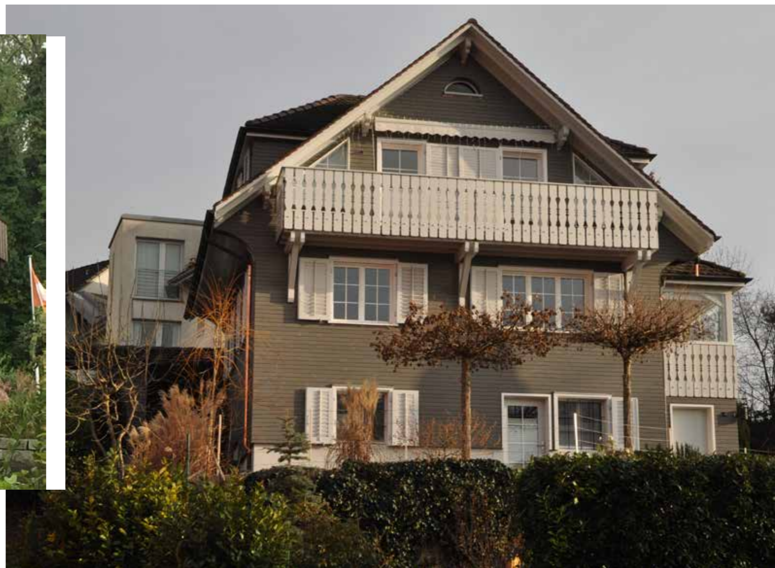
Links: Nordwest-Ansicht des Holzhauses mit der alten Schindel-/ Blech-Fassade
